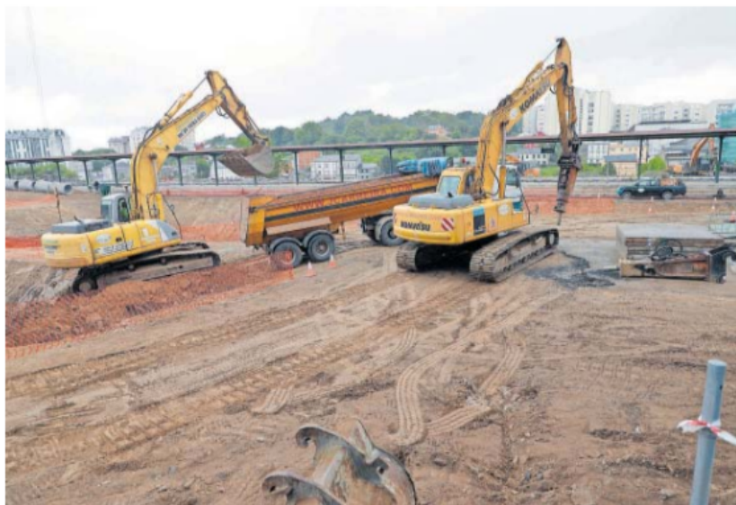
Máquinas trabajando en la construcción de la estación intermodal de Lugo (Galicia). P. E. A. T. (EFE)
